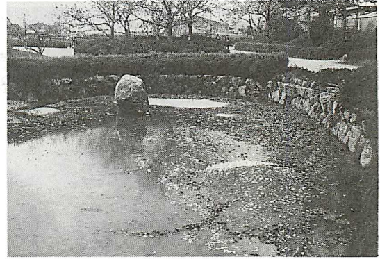
図13 改修後の調整池 (1999. 4. 11). 図9と同じ場所。県の工事責任者と協議し、水が枯れて池が乾燥することがないように、水門を調整してもらっている。写真左側から水が流れ込む。
