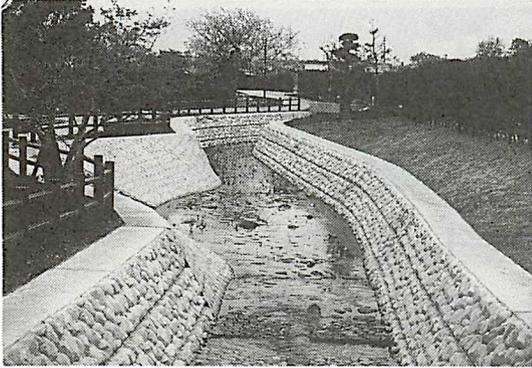
図12 改修された小水路 (1999. 4. 11). 河川改修に当たっては生き物に配慮するよう建設省が通達を出して10年近くが経つが、相変わらずこのような工事が行われている。見た目を良くしただけの完全な3面コンクリート護岸である。
