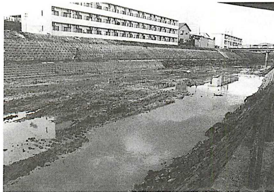
写真3 河床改修により植生が失われた大正川河床(1996年1月4日撮影)。
